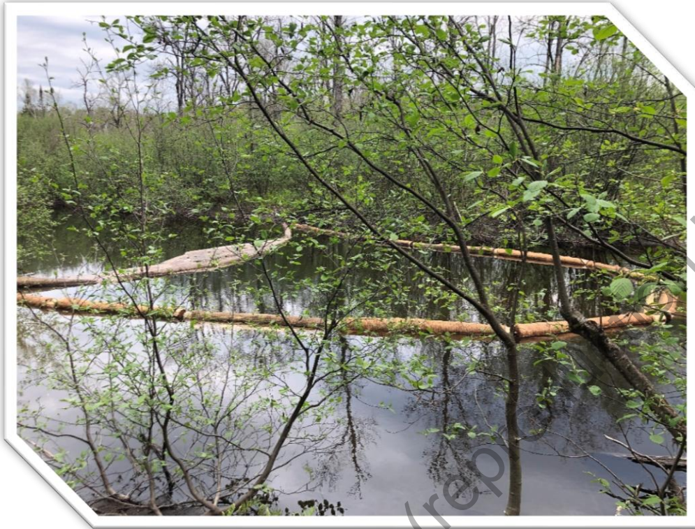
Figure 2 : Estacade installée dans le ruisseau Jourdain à Nominugue pour limiter la dispersion de fragments de myriophylle à épis.
