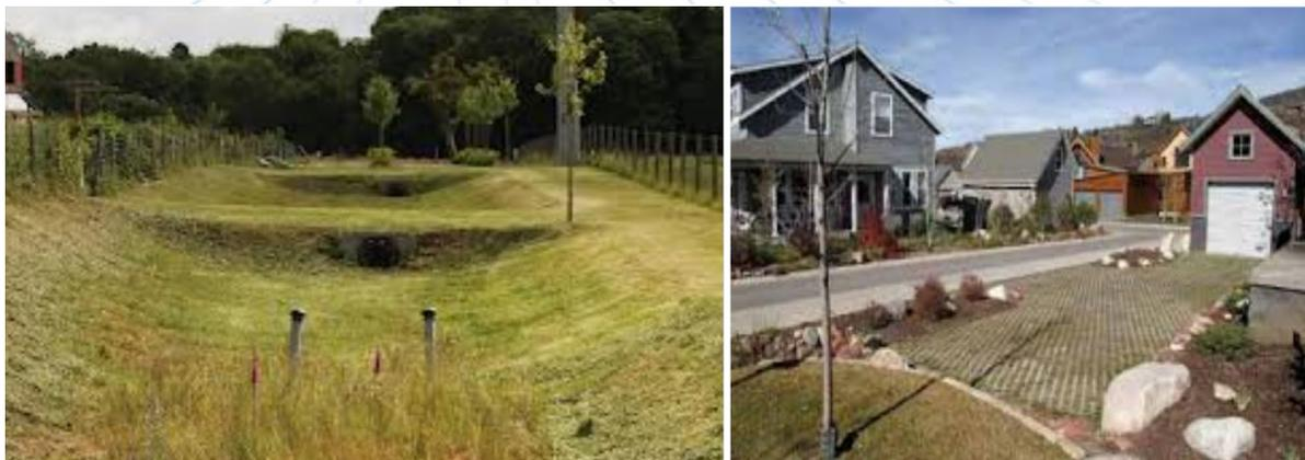
Exemple d'aménagement d'un bassin d'infiltration et d'un pavé poreux (Projex et ROBVQ)
