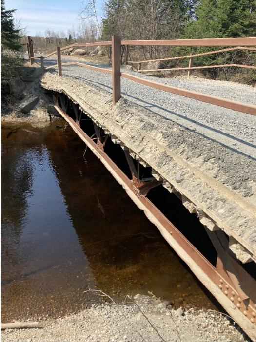
**ER6 – Signes d'érosion des berges, accumulation de sédiments en bordure du pont**
