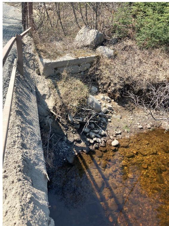
Figure 20 : Pont d'une route de gravier sans ouvrage de rétention des sédiments et signes d'érosion et d'accumulation de sédiments en bordure de l'infrastructure au site ER6
