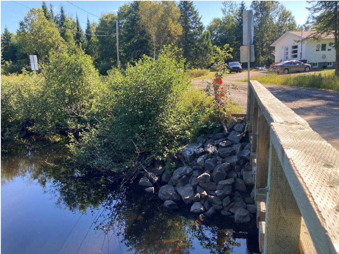
Figure 23 : Enrochement de la rive en bordure du pont sur le chemin des Groseilliers au site ER14
