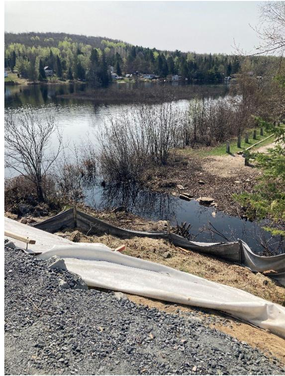
Figure 19 : Mesures mises en place pour limiter l'apport de sédiments dans le lac Barrière près du pont de la piste cyclable du P'tit Train du Nord au site ER5
